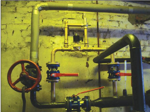
Рис. 2. Установка PPT в тепловом узле.
